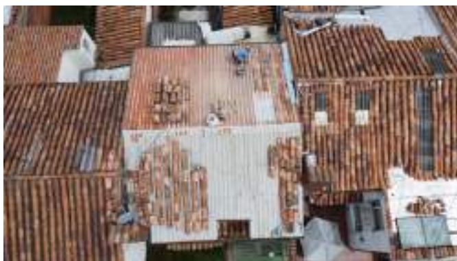
Imagen 26. Intervención arreglos cubiertas casas
