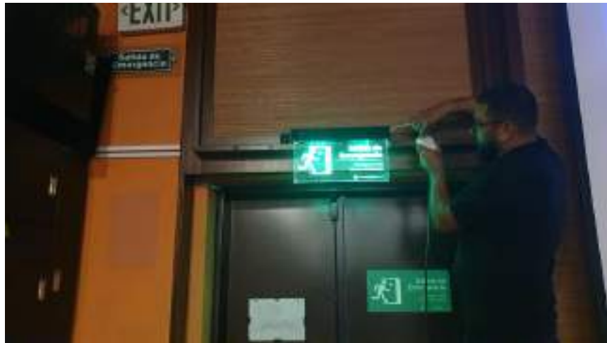
Imagen 15. Instalación de señalización
